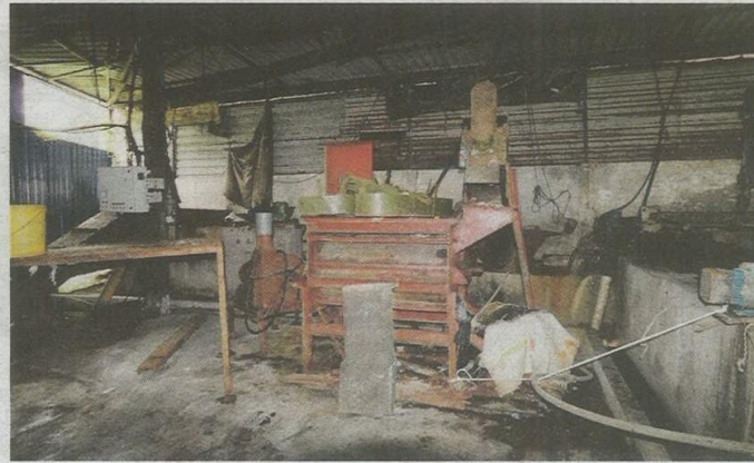
Keadaan kilang yang didapati tidak mengikut spesifikasi.
